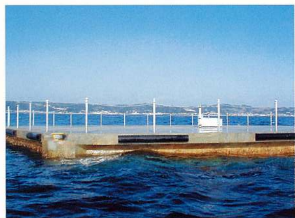
敷設したヘキサフロート
