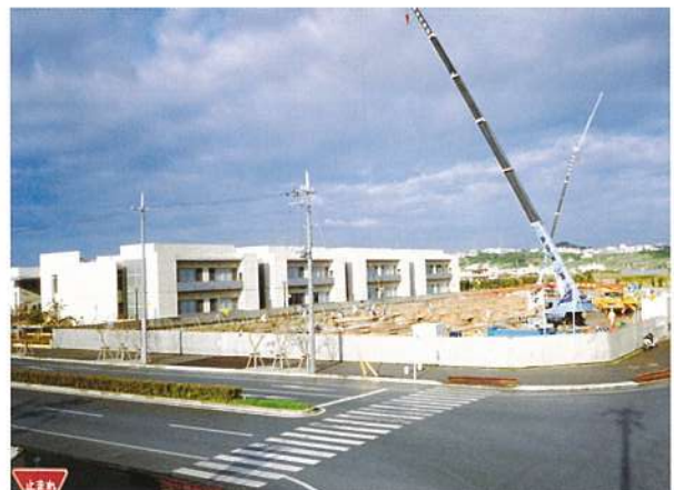
建築中の状況
